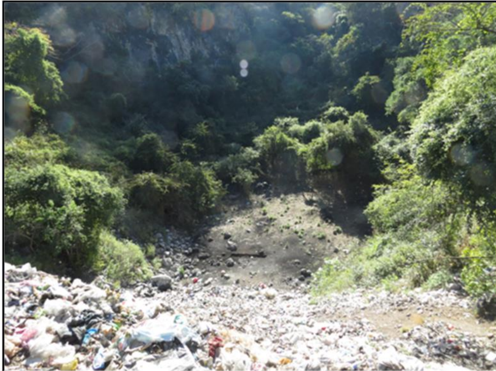
Imagen de los autores del informe 023 05 de diciembre de 2014. Imagen de la base de la ladera que muestra los cambios observados por miembros del EAAF presentes en la primera inspección del lugar en octubre de 2014.
