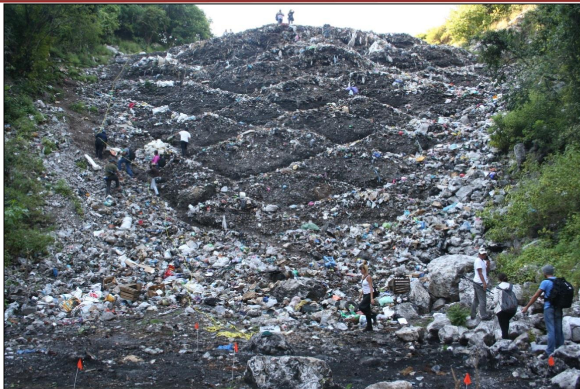
Ilustración4: Zona B, Vista de la pared de basura (27/10/2014).
